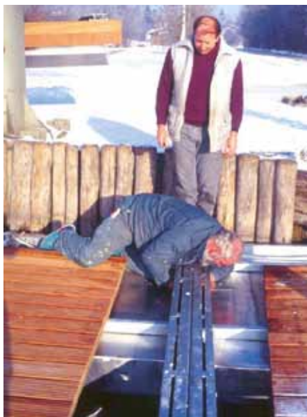
Bau Startprahm Renner II
