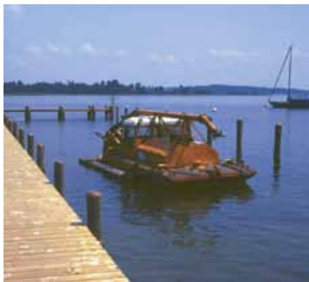
Saugbagger zur Schlammmentfernung und zur Erhöhung der Wassertiefe
